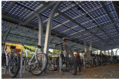
Mit Glasfolienlaminat-Solarmodulen überdachter Fahrradabstellplatz Quelle: Galaxy Energy GmbH
