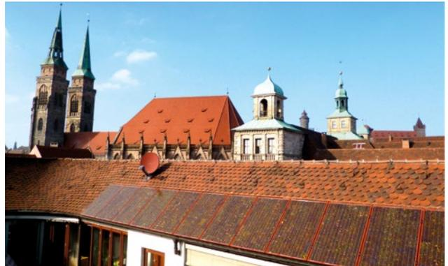
In Nürnberg wurde das Neue Rathaus, in Abstimmung mit der unteren Denkmalschutzbehörde, mit Photovoltaikmodulen ausgestattet. Dabei setzten die Beteiligten rote PV-Module als dachintegrierte Lösung ein, deren Modulrand terracottafarben ist.
