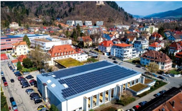
In Waldkirch wurde die Stadthalle, die ein wenig tragfähiges Dach auswies, trotzdem mit Solarmodulen ausgerüstet. Zum Einsatz kamen hier besonders leichte Photovoltaikmodule. Quelle: Stadt Waldkirch
