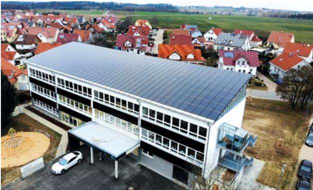
Die aktiv genutzte Solarfassade und die PV auf dem Dach der Schule in Pfahlheim (Ostalbkreis) tragen mit 106 kW<sub>p</sub> maßgeblich zum Plus-Energie-Standard bei. Der Sonnenstrom wird bei Bedarf im Speicher bevorratet und wird auch für die Beheizung mit Wärmepumpen & Heizstäben genutzt. Quelle: Ingenieurbüro Neue Energien Freiheit-Consulting
