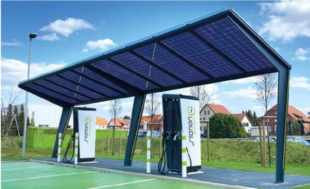
Mobilitätsstation mit Zusatzservices: Lädt E-Autos und verbindet das mit Solarstrom, Informationsdisplay für Bürger, Paketstation, Getränkeautomat, LED-Beleuchtung, Sitzbank, W-LAN Hotspot, usw. – je nach Bedarf.
