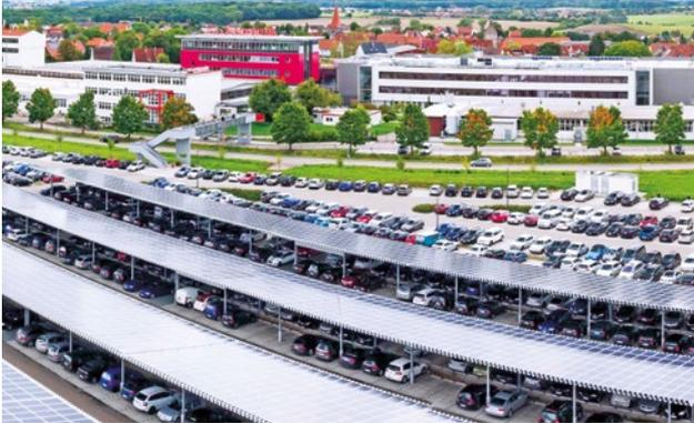
Als Parkplatzüberdachung haben Solarmodule einen doppelten Nutzen: Neben dem Schutz von 350 Fahrzeugen wird hier in Illshofen (Landkreis Schwäbisch Hall) gleichzeitig Solarstrom erzeugt.
