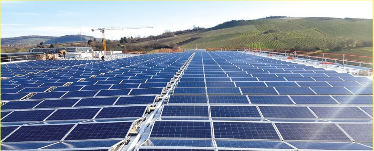
Parkhaus in Neckarsulm produziert Sonnenstrom: Das Dach ist vollständig mit Photovoltaik belegt. Knapp 2000 Module liefern eine Leistung von 520 kWp. Quelle: Orange Solar GmbH
