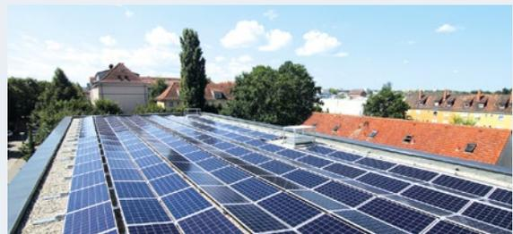
Die 99 kW-Photovoltaikanlage auf dem Dach liefert den Strom direkt an die Probühne des städtischen Theaters.
