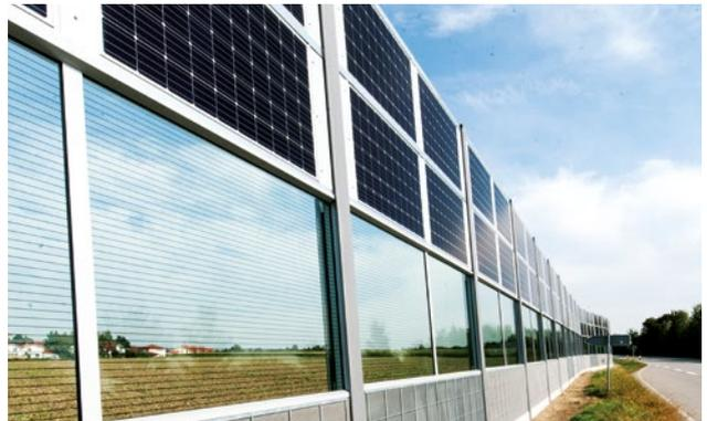
Auch in Lärmschutzwände können Solarzellen integriert werden.
