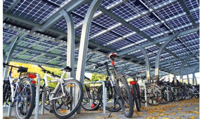
Doppelglas-Solarmodule eignen sich besonders für den Einsatz in Wintergärten, Carports oder anderen integrierten Solar-Lösungen wie hier bei einem Fahrrad-Unterstand, der gleichzeitig Strom erzeugt.
